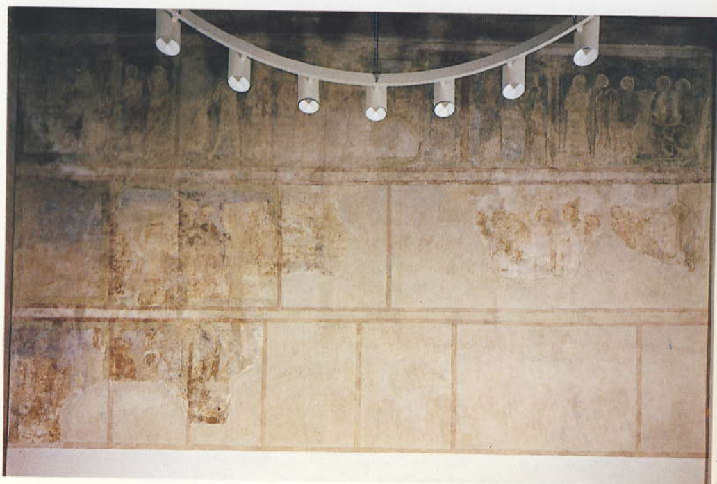
219 Zustand nach der Restaurierung 1979.
