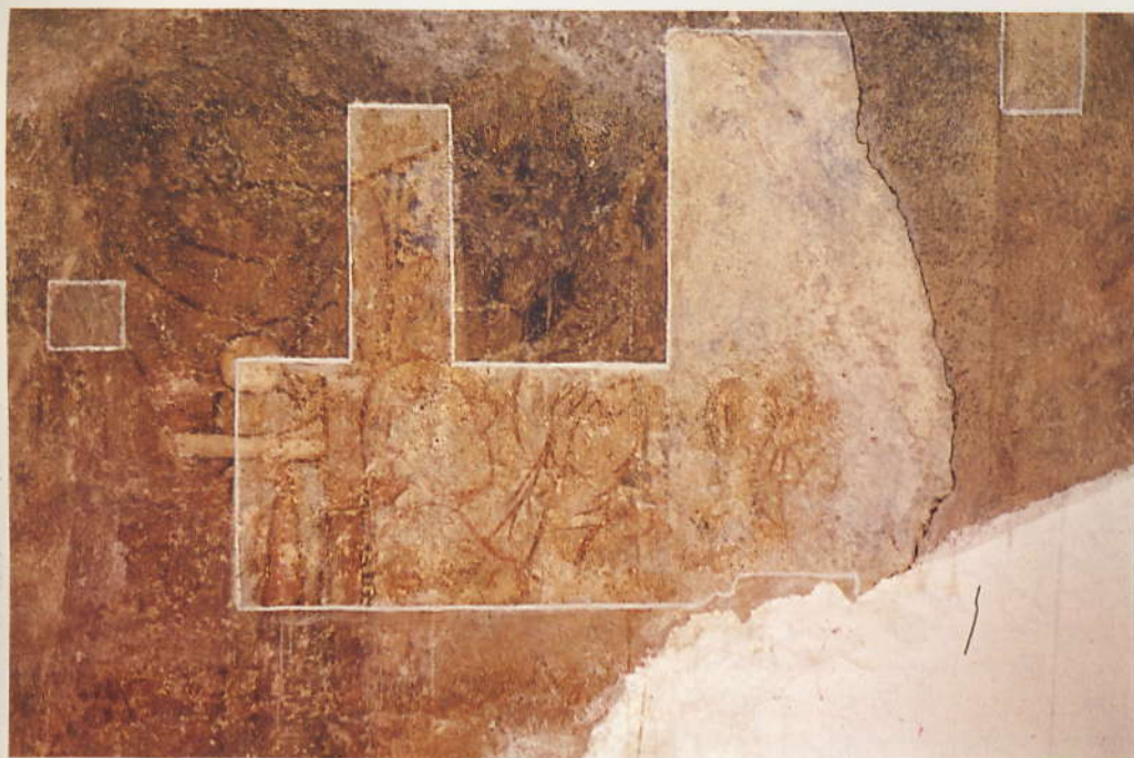
220 Köln, St. Cäcilien, Reinigungsprobe an der Nordwand.
